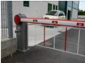
Motoréducteur 24 volt avec armoire de commande et récepteur intégré
